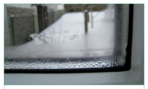
Abb. 3: Durch den Aluminium-Abstandhalter im Isolierglas kann am Rand der Glasscheibe leicht Tauwasser entstehen.
